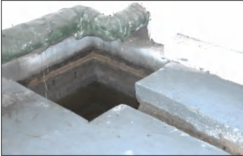
图 4.2-1 催化剂车间导流槽和导流沟
