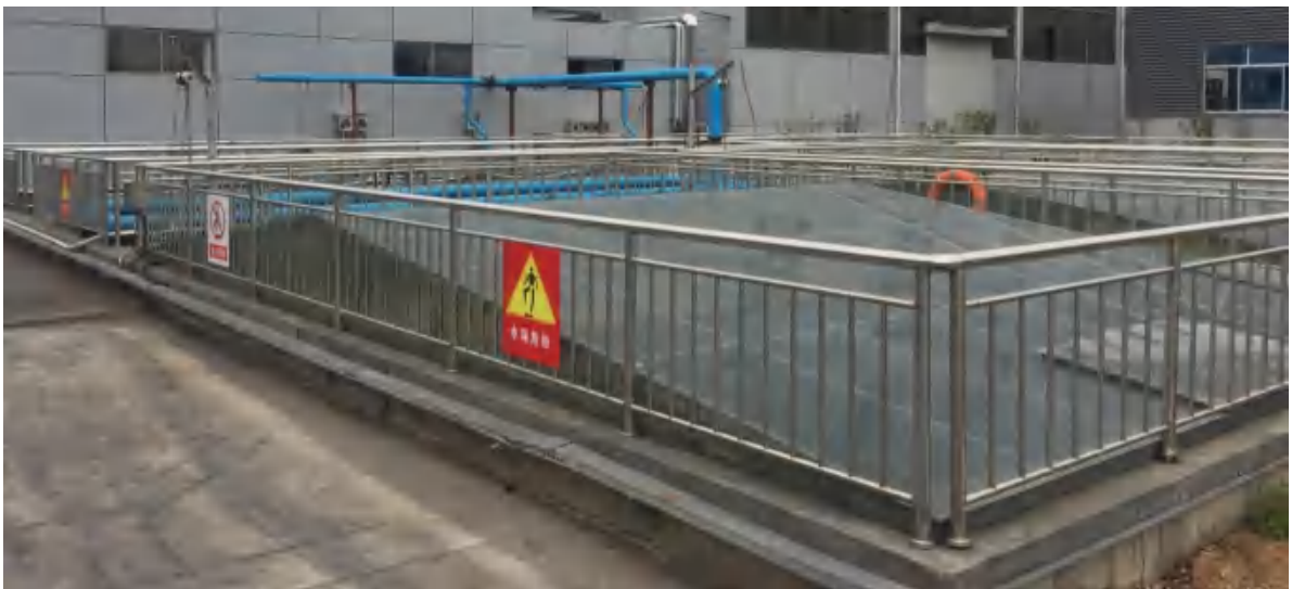
图 4.1-4 厂区污水处理站
