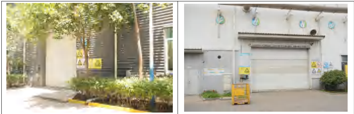
图 4.1-6 危险废物暂存间
