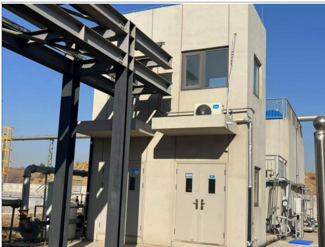
三级防控：污水处理站事故缓冲池
